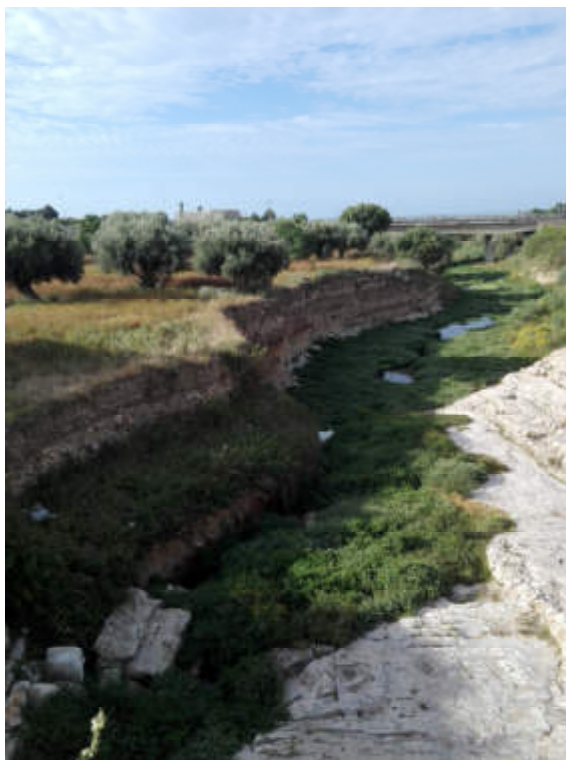
Foto 13 - Fenomeno di erosione di sponda lungo il Torrente di Modica in C.da Cerasella
