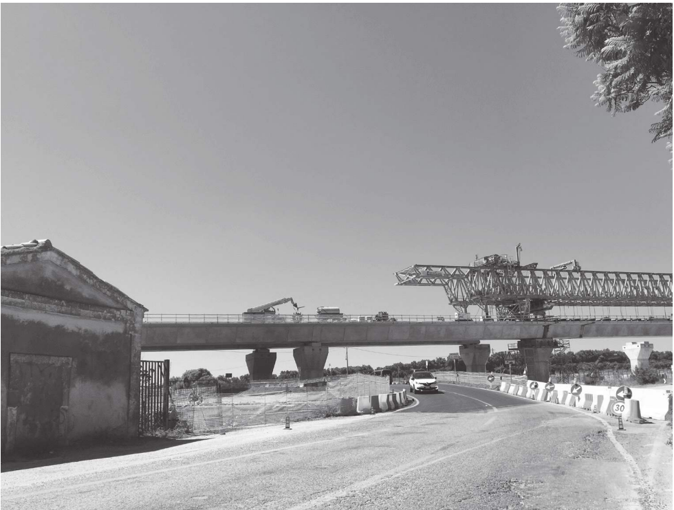
Cantiere autostrada, Modica-Pozzallo
