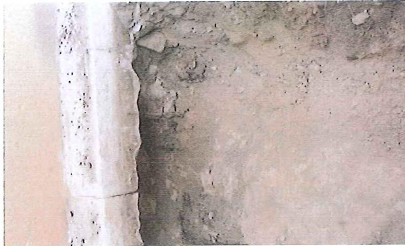
**FOTO 1 - 2** - Pozzetto esplorativo lato nord fabbricato. Si nota che le fondazioni poggiano sulle calcareniti.
